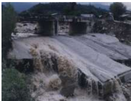
پل آلیش رود
